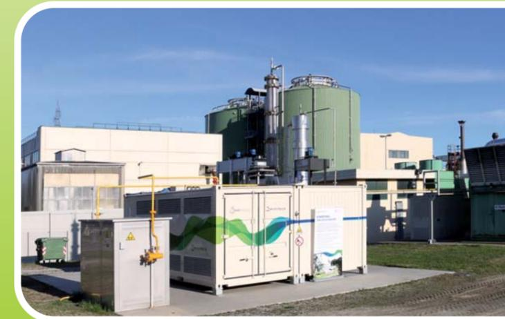
Il **Biometano** è ottenuto presso l'impianto di **Acea Pinerolese** attraverso un processo di valorizzazione del biogas ottenuto dal processo di trattamento anaerobico del rifiuto organico.
